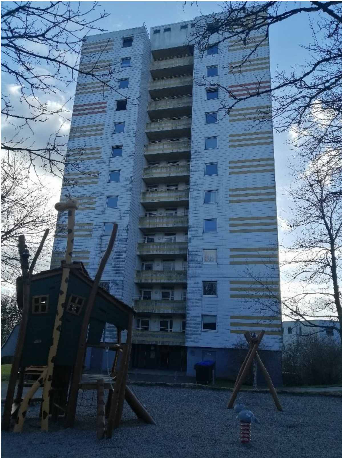
Vue de face avec entrée
